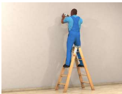
Fig. 56 Position sûre sur un escabeau à marches accessible des deux côtés
