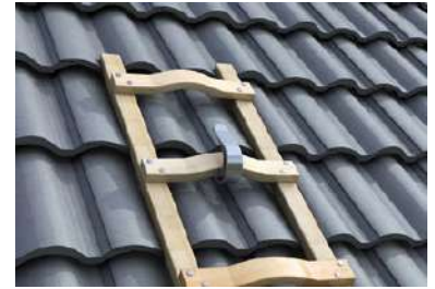
Fig. 66 Appendere la scaletta di sostegno del tetto
