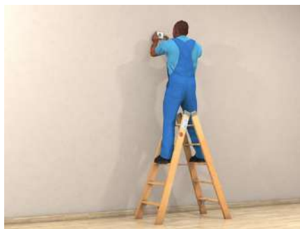
Abb. 56 Sicherer Stand auf einer beidseitig begehbaren Stufenstehtleiter
