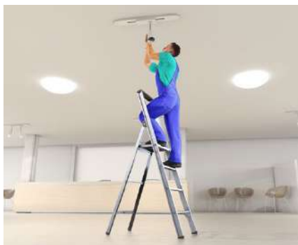
Fig. 57 Position sûre sur l'escabeau avec plate-forme
