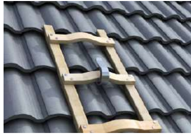
Fig. 66 Accrocher l'échelle de support de toit
