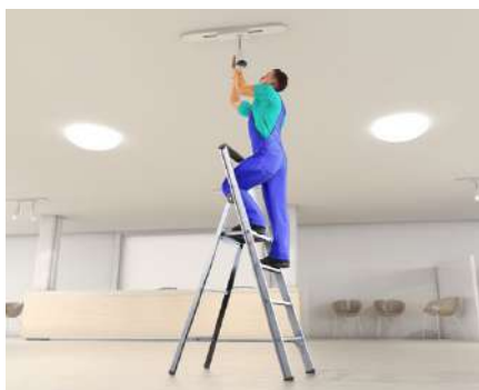
Abb. 57 Sicherer Stand auf der Stehleiter mit Plattform
