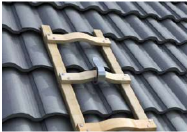
Abb. 66 Einhängen der Dachauflegeleiter
